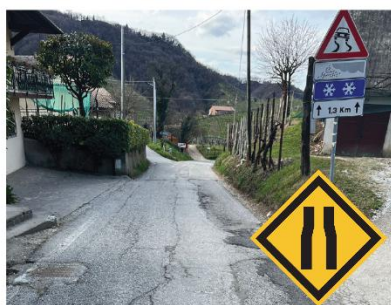
4 - Guia verso Follo Restringimento carreggiata
