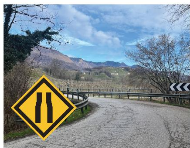
9 - Ponte verso Combai SP 152 Restringimento ponte
